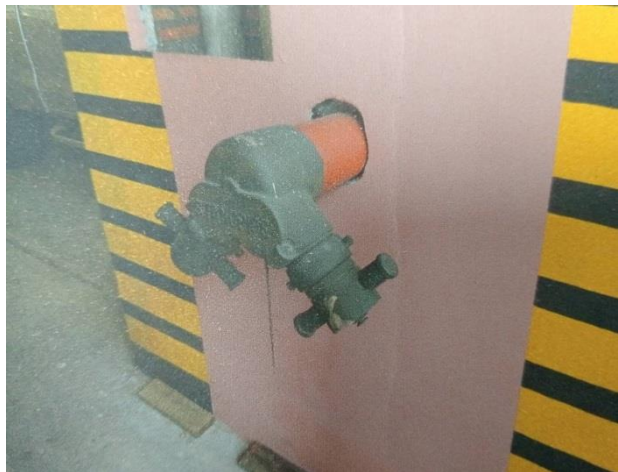
รูปที่ 18 ระบบท่อเย็นและหัวรับน้ำดับเพลิง
