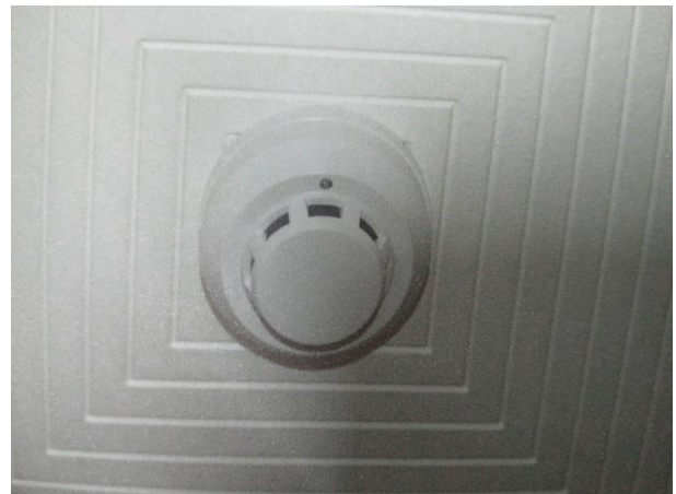
รูปที่ 19 เครื่องตรวจจับความร้อน
